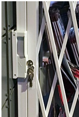
Skjutregel i fjädrande golvhylsor. Lås mot vägg.
